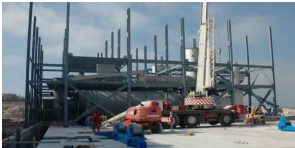
Μονάδα ξήρανσης ιλύος σε φάση κατασκευής
