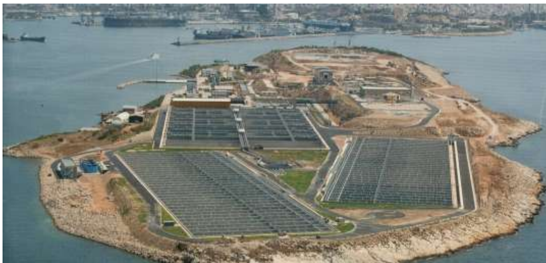
Γενική άποψη των έργων του Β.Π. Ψυττάλειας
